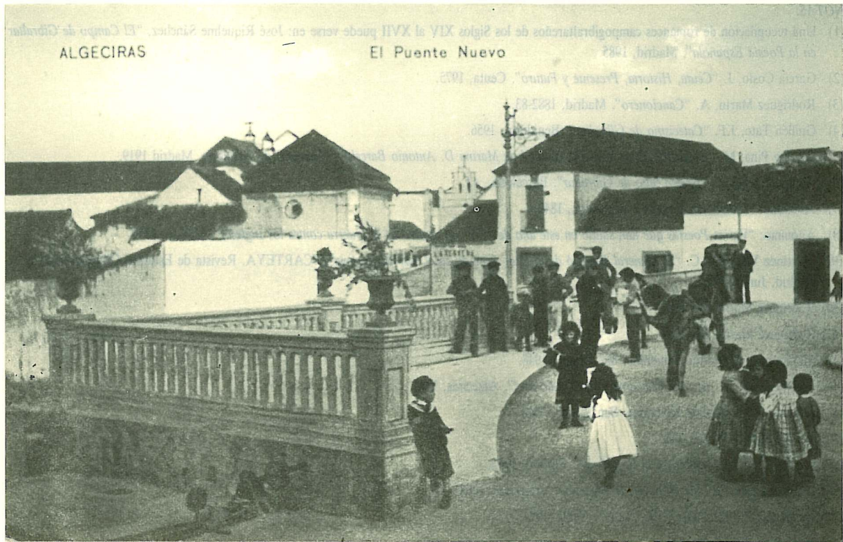
Juegos infantiles junto al Puente Nuevo de Algeciras.
