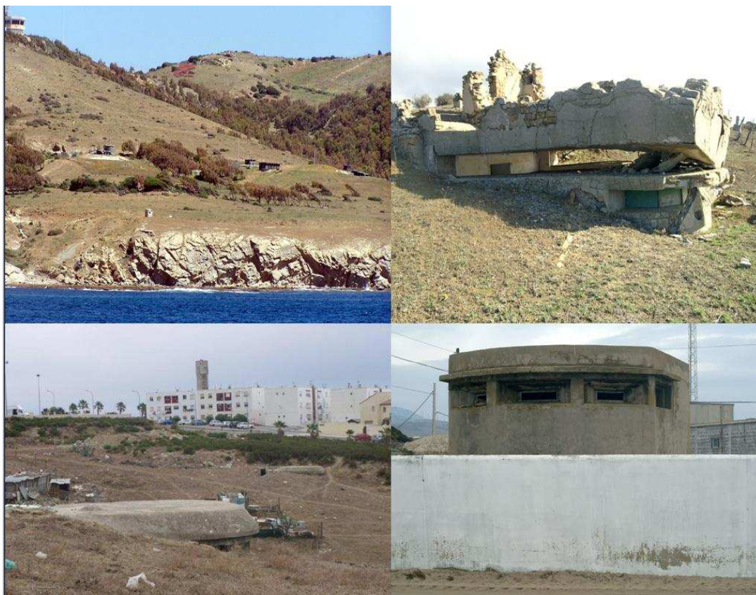
Imagen 3. Diversas obras de fortificación en Tarifa. (Archivo del autor)
