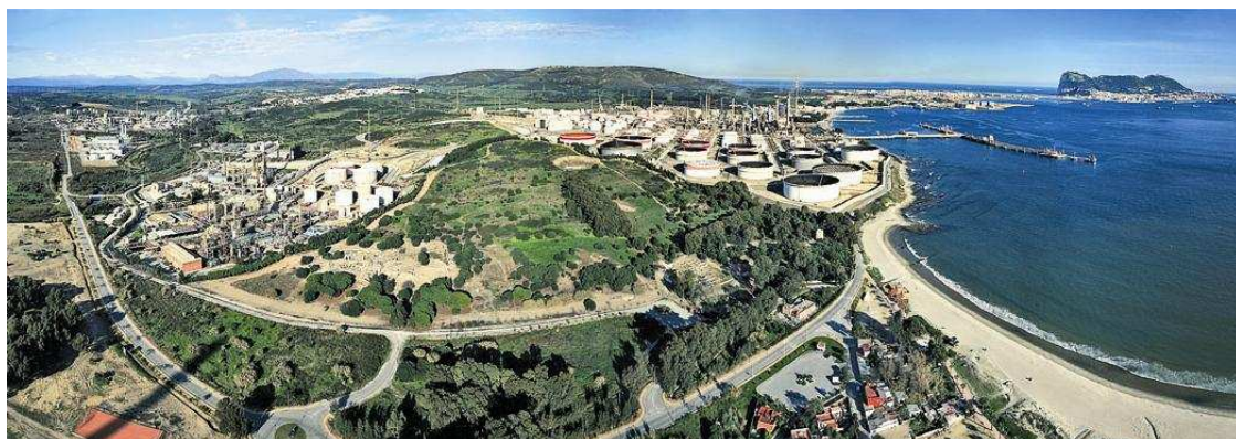
Fig. 177. Aspecto actual del entorno de Carteia , rodeada por instalaciones industriales y diferentes infraestructuras (Paisajes Aéreos S.L., 2009).
