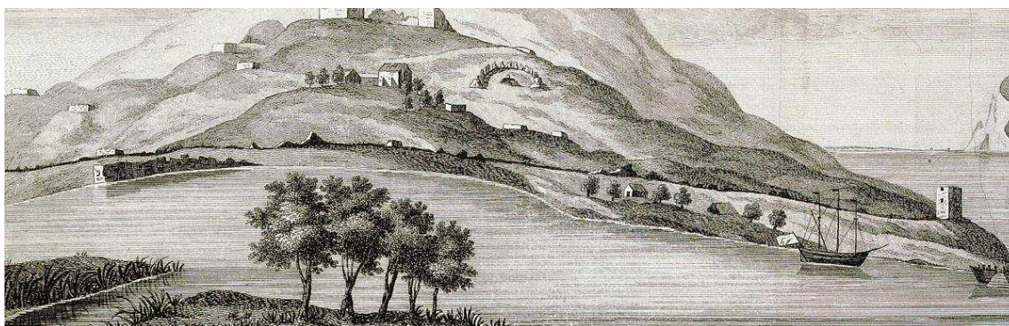
Fig. 179. Detalle de la vista de F. Carter, con los restos entonces visibles de la muralla antigua de Carteia. 1771 (MP. 288 y 488).
